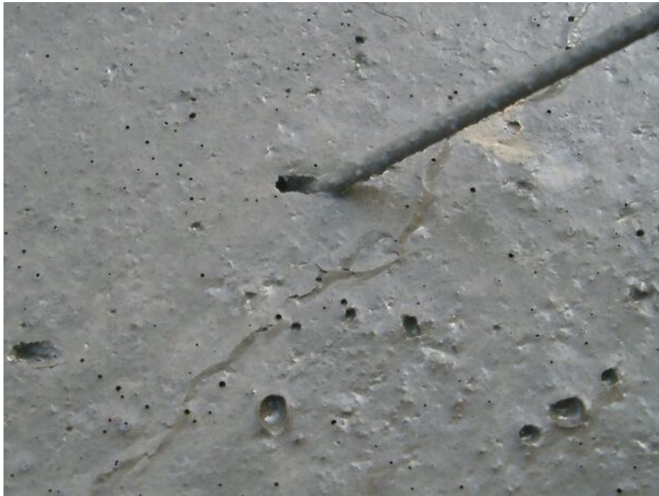
Figur 4.7 Vid nedstickande av en metallstav uppmättes stenen vid ca 1 cm djup från ytan, vilket tyder på att bruksseparation hade ägt rum.
