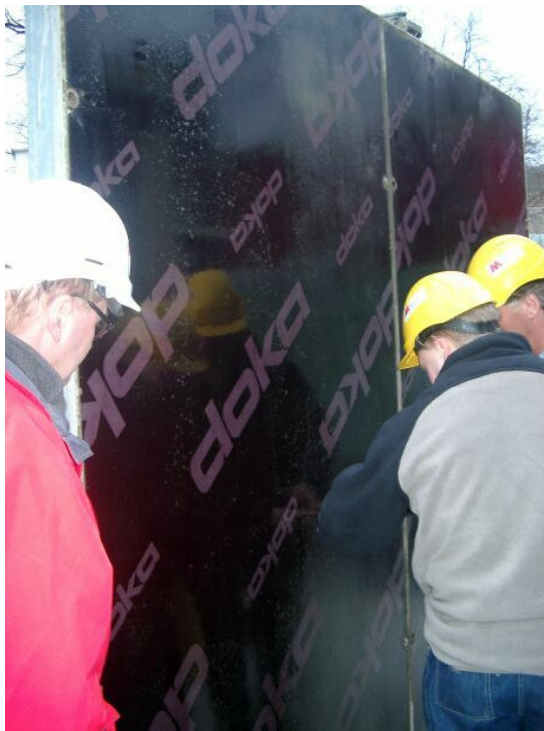
Figur 4.13 Som formmaterial användes nya plyfaformar av fabrikket Doka.
