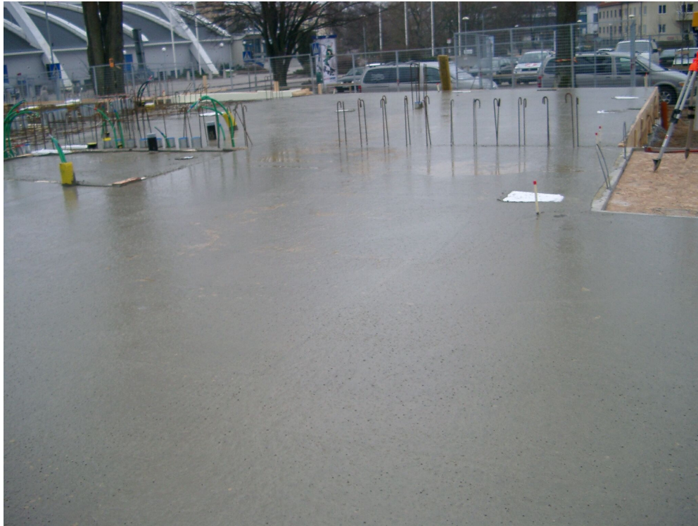
Figur 4.5 En tydlig minskning av vattenseparation kunde observeras. Det s.k 'brunvattnet' på betongytan uppträdde nu endast fläckvis jämfört med gjutningen av den första bottenplattan.
