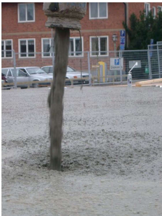
Figur 4.3 a och b Lossning skedde med pump vid gjutning av den tredje bottenplattan.
