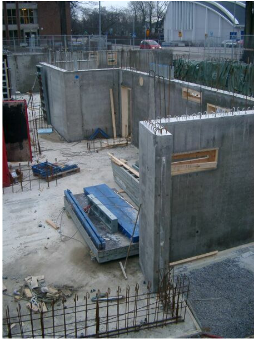
Figur 4.9 SKB användes i alla platsgjutna vertikala stomkonstruktioner.
