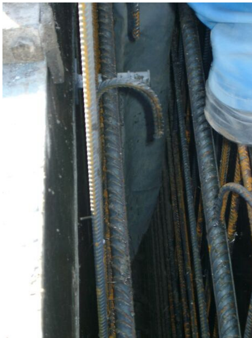
Figur 4.15 Strumpan försöktes placeras mellan armeringen ner till betongens nivå.
