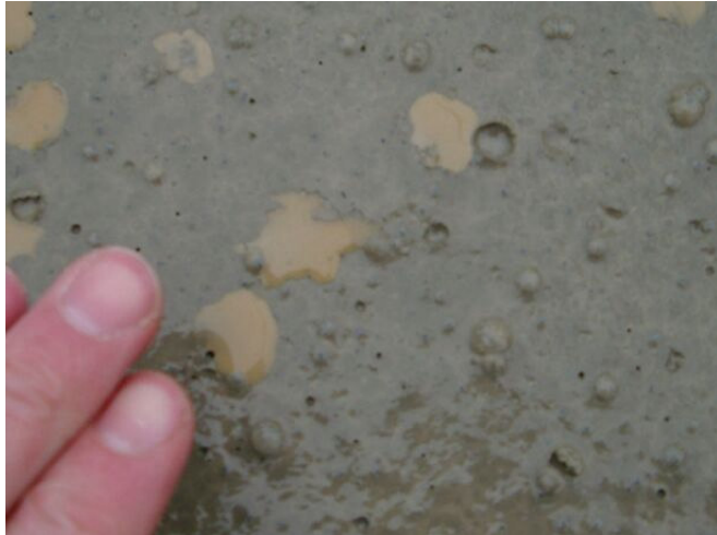
Figur 4.6 Stora såväl som små luftbubblor kunde observeras även efter att bottenplattan hade slodats.
