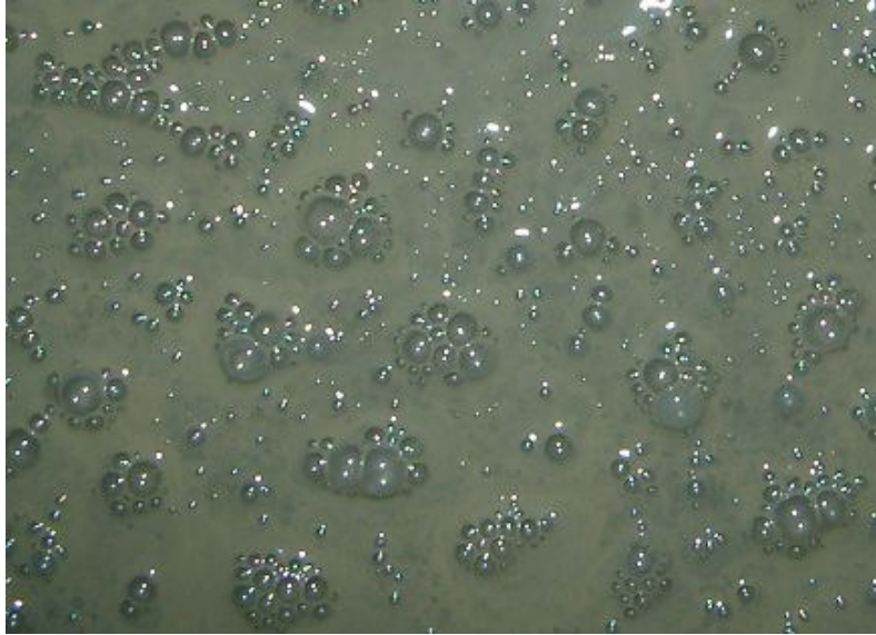
Figur 5.6 Närbild av bubblor i betong.
