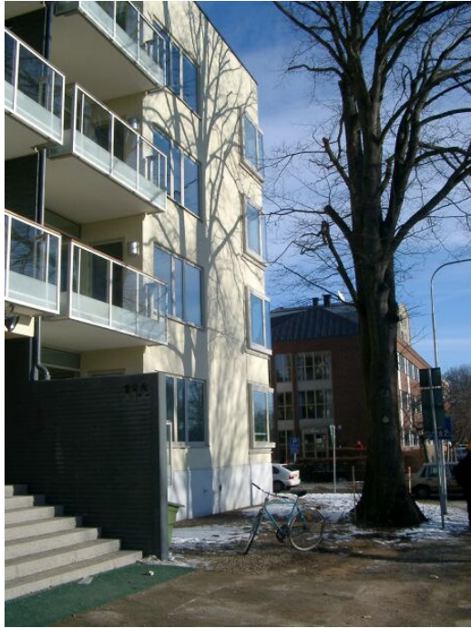
Figur 4.1 Inflyttningsfärdigt hus i flerbostadsprojektet där fältstudierna har bedrivits.
