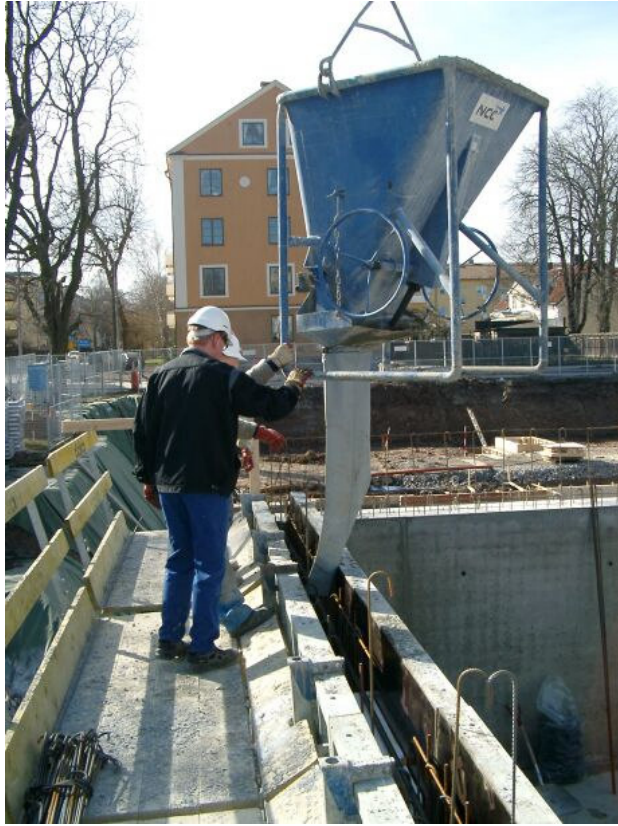
Figur 4.14 Som lossningsmetod vid väggjutningarna användes i huvudsak bask med strumpa.
