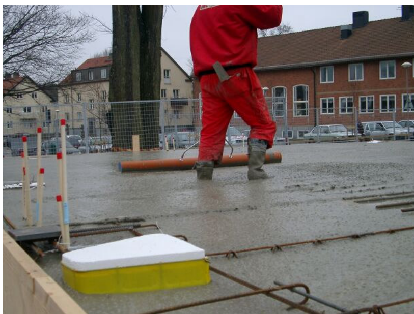
Figur 4.4 Betongen slodades med s.k 'rörsloda' direkt efter lossningen.
