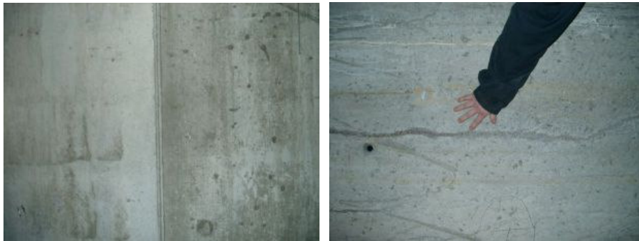
Figur 5.1 a och b Exempel på bristande ytkvalitet som medförde att efterarbete inte kunde undvikas.
